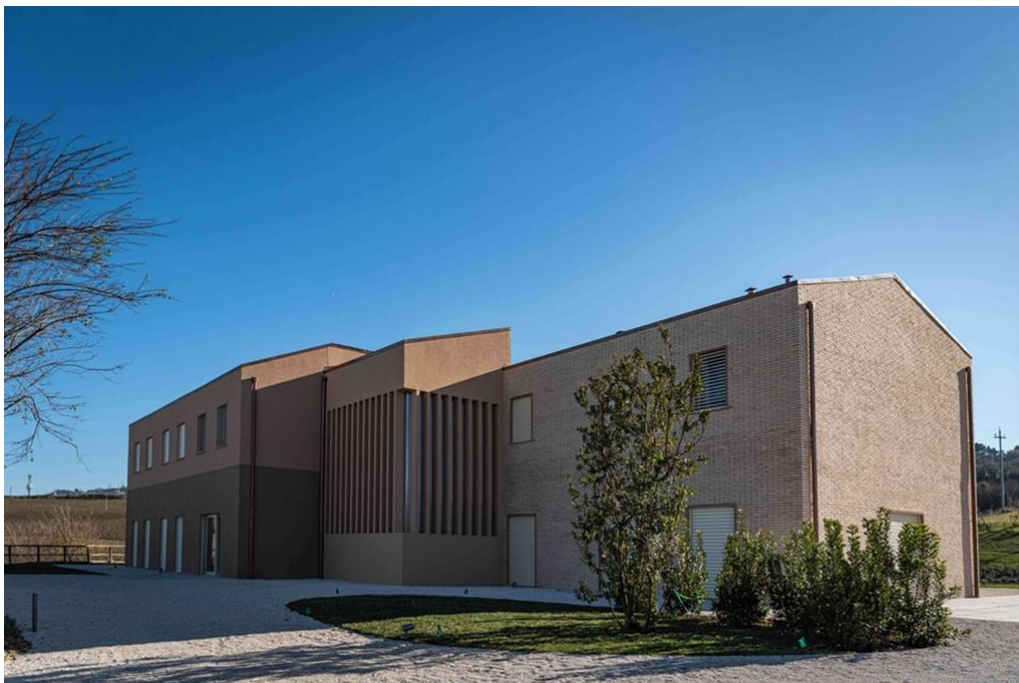
Il Casale Angelini appena ristrutturato
