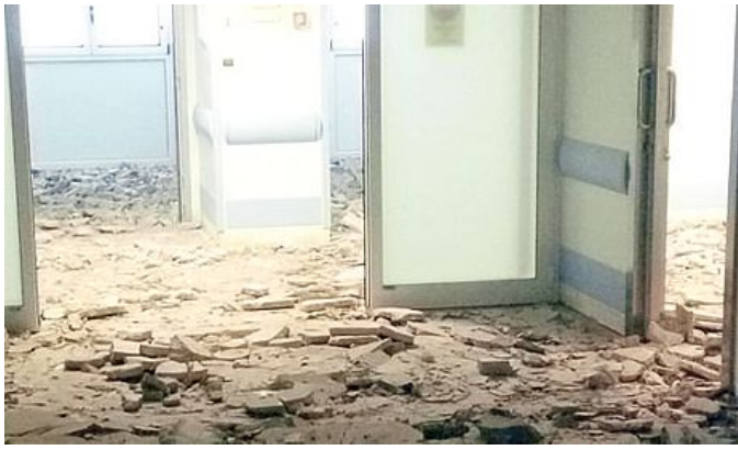
I lavori di rifacimento della pavimentazione a Rianimazione centrale
