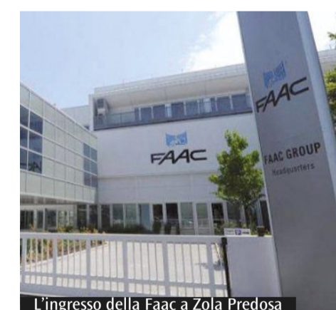
L'ingresso della Faac a Zola Predosa
