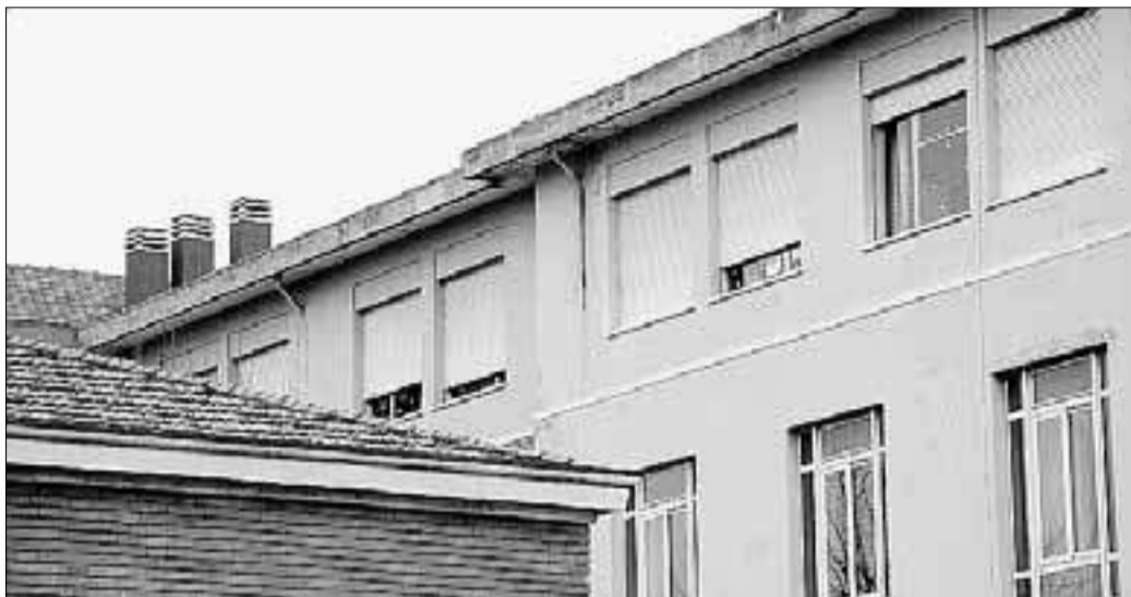
Spazzacamin Esistono ancora caldaie pubbliche di vecchio tipo a gasolio Migliorini
