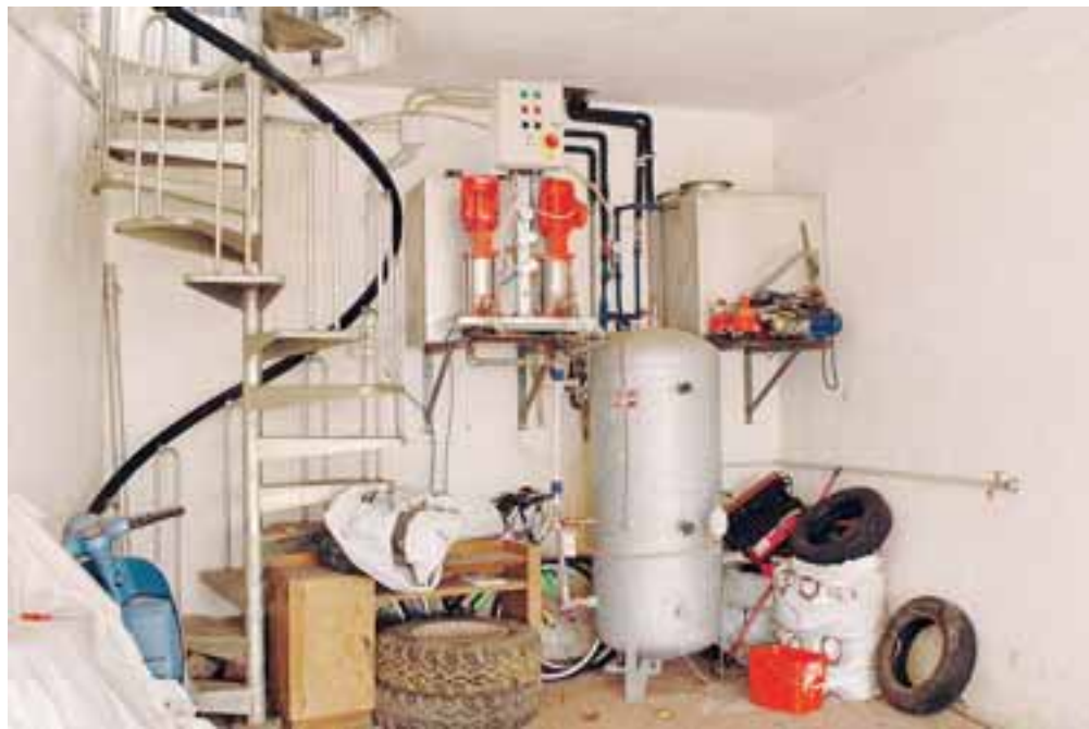
Un'autoclave in un'abitazione privata a Montesicuro: l'unico sistema per avere l'acqua a tutte le ore
