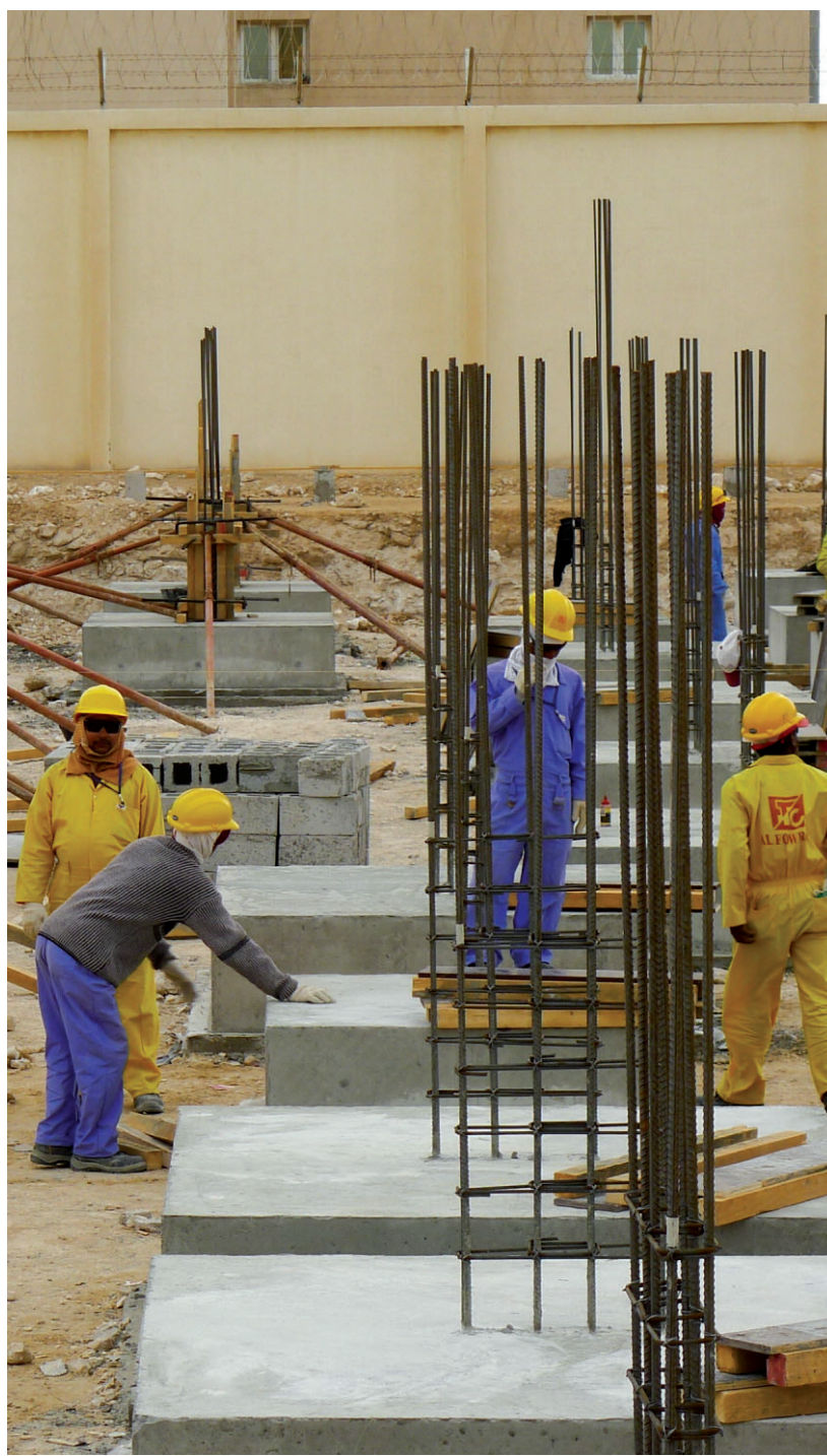
Un cantiere di Doha per i Mondiali del 2022 FOTO INFOPHOTO
